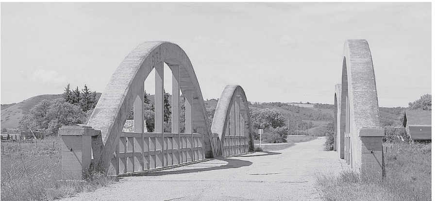
Old cement bridge - Qu'Appelle Valley
